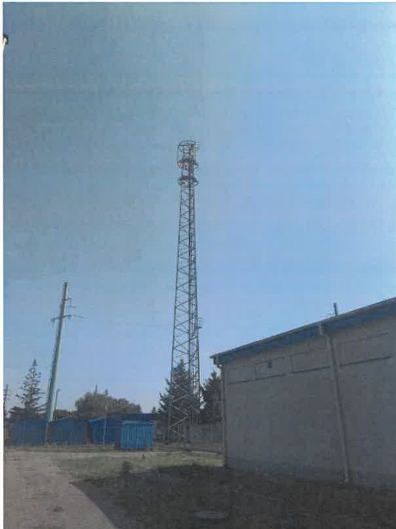
Widok obiektu wraz z zainstalowanym zespołem antenowym
