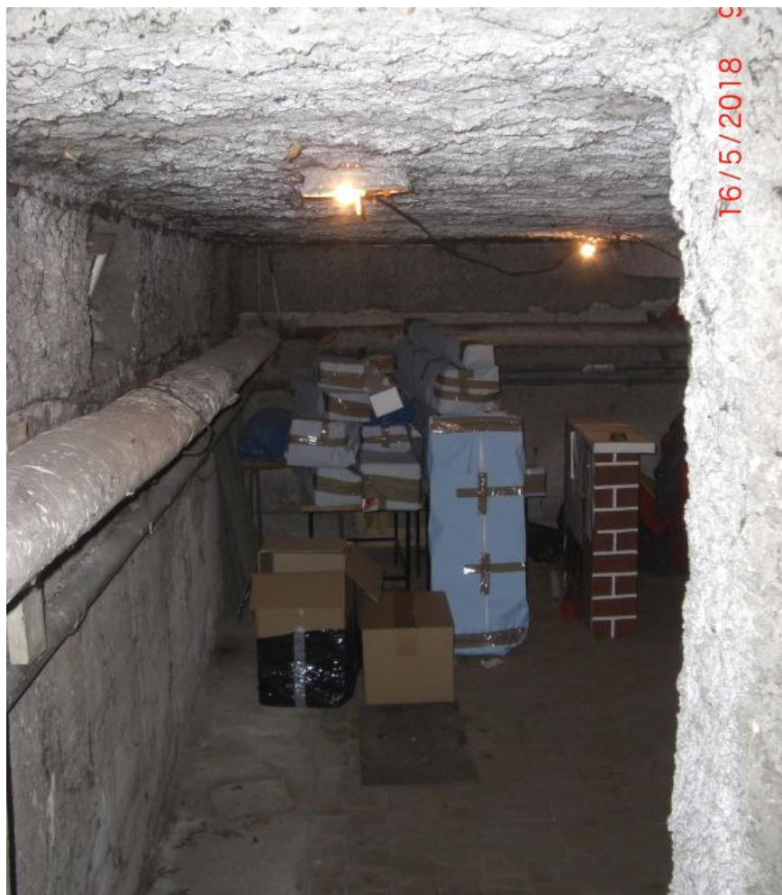
Fot. Pomieszczenie -101, tynk w bardzo złym stanie, w całości do skucia (wymiany)
