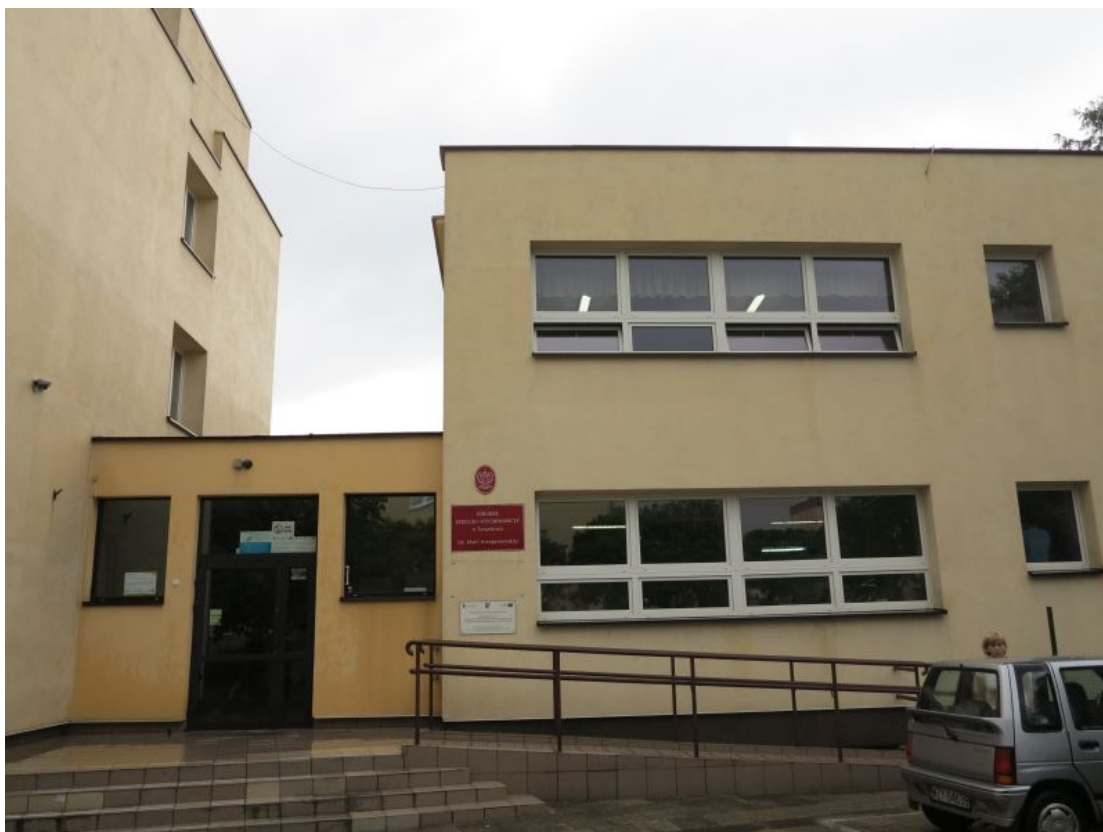
Fot. Elewacja frontowa. Parterowy łącznik do rozbiórki, w jego miejscu wstawienie 3 kondygnacyjnego łącznika w konstrukcji stalowej, modułowej. Rozbiórka schodów zewnętrznych i podjazdu, zamiast tego projektowane podwyższenie terenu z niewielkim spadkiem w stronę furtki – wejścia na teren Ośrodka.
