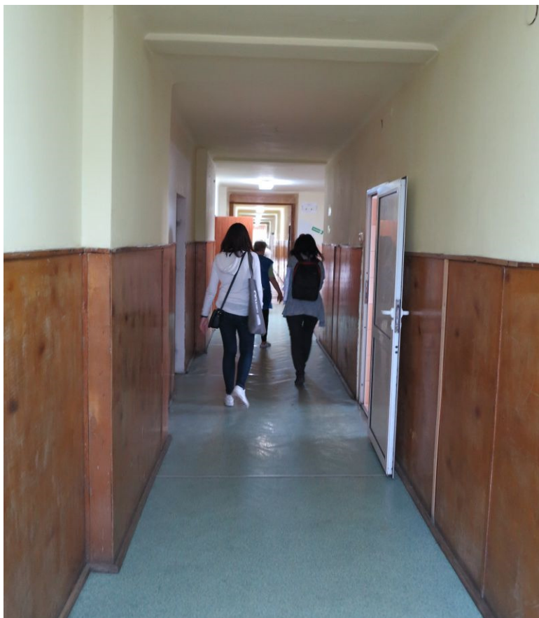
Fot. Korytarz – demontaż lamperii drewnianych, naprawa tynków, szpachlowanie i malowanie ścian, wymiana posadzek, poszerzenie i wymiana drzwi, projektowane sufity podwieszane akustyczne
