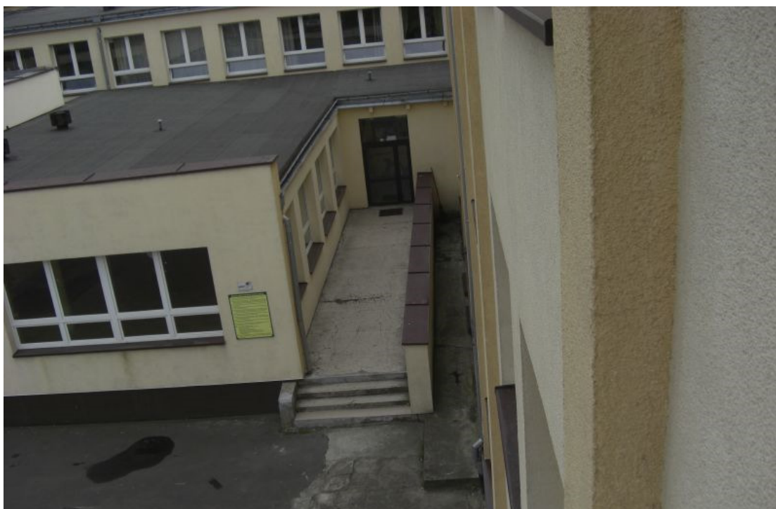
Fot. Wejście główne od boiska. Rozbiórka schodów i podestu, wyprofilowanie nowej nawierzchni z niewielkim spadkiem, według rysunku zagospodarowania. Rozbiórka murka do poziomu nowej nawierzchni, wprowadzenie nowej balustrady ze stali nierdzewnej wysokości 1,1m.
