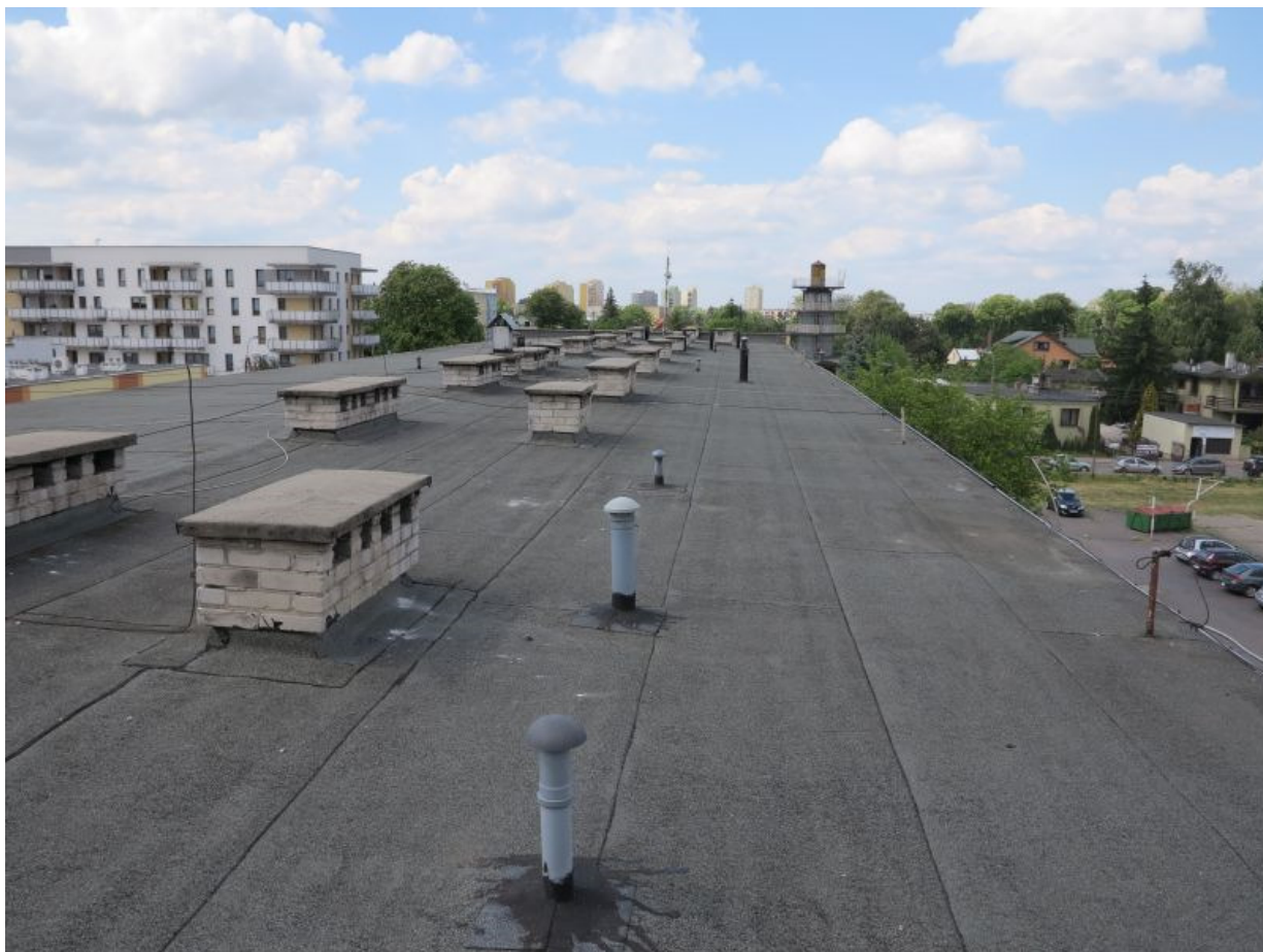
Fot. Dach nad internatem, do docieplenia i remontu
