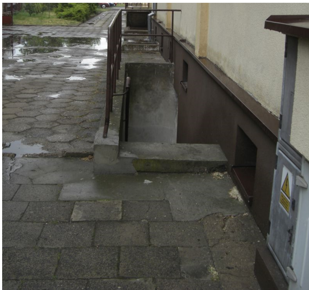
Fot. Schodki do uzupełnienia, okno piwniczne do zamurowania
