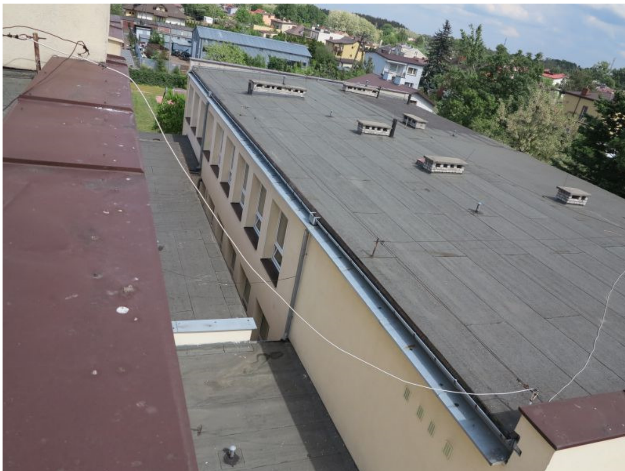
Fot. Dach nad skrzydłem szkolnym, widoczna przerwa między budynkami do wypełnienia świetlikiem. Z przodu parterowy łącznik do rozbiórki i wstawienia nowej 3 kondygnacyjnej zabudowy modułowej
