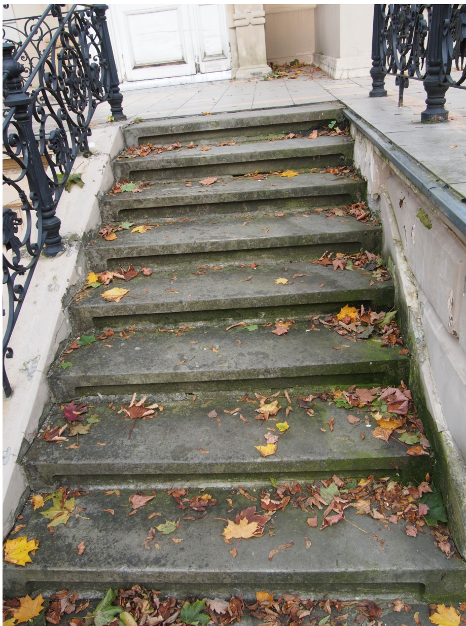
Fot. nr 7. Pałacyk Muzeum Mazowsza Zachodniego w Żyrardowie. Elewacja ogrodowa. Górna część prawego ciągu schodów. Całość mocno zawilgocona wraz z murkami. Płytki tarasu powyżej górnego stopnia i zachodzą na niego. Okap murku z boku nie spełnia roli i zwiększa zawilgocenie murku i schodów.
