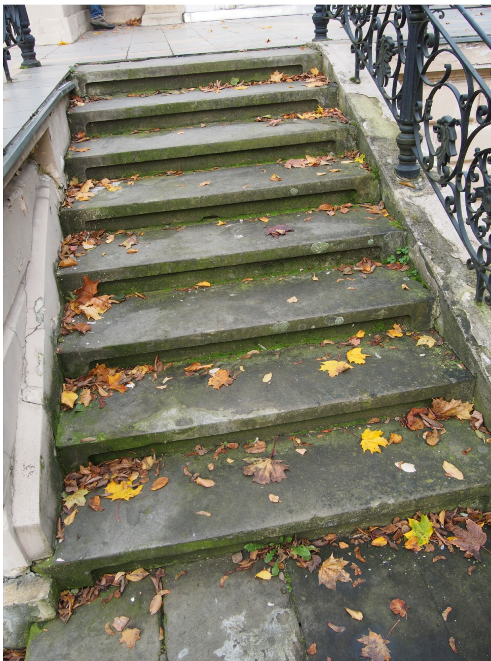
Fot. nr 8. Pałac Muzeum Mazowsza Zachodniego w Żyrardowie. Elewacja ogrodowa. Górna część lewego ciągu schodów. Sytuacja analogiczna do ciągu prawego. Wadliwe obróbki blacharskie odpadają. Zniszczenia duże w narożnikach stopni przy murkach, ubytki, uzupełnienia cementowe, korozja biologiczna. Fugi wykruszają się. Duże zniszczenia widoczne w płytach spocznika. Murki obramienia schodów w stanie tragicznym.
