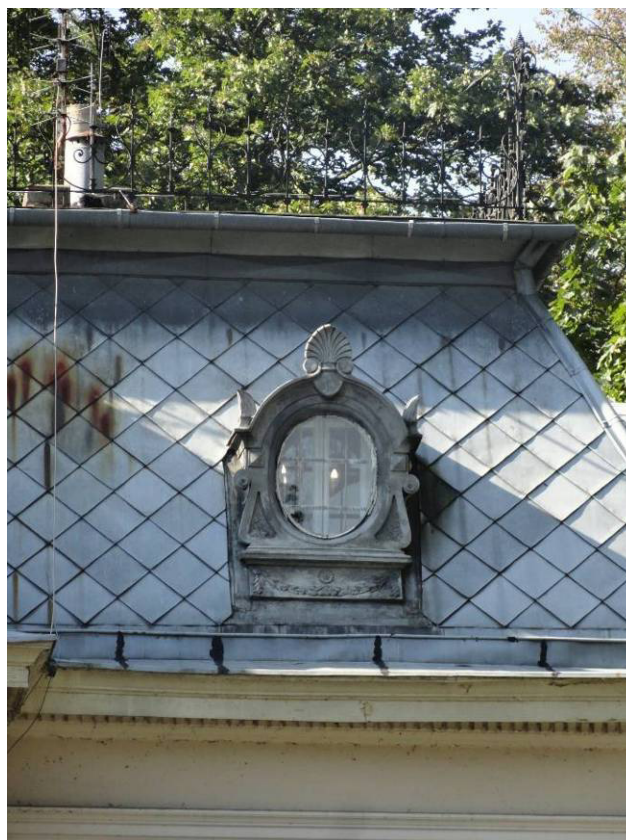
F10 Widok połaci mansardowej – lukarna boczna
