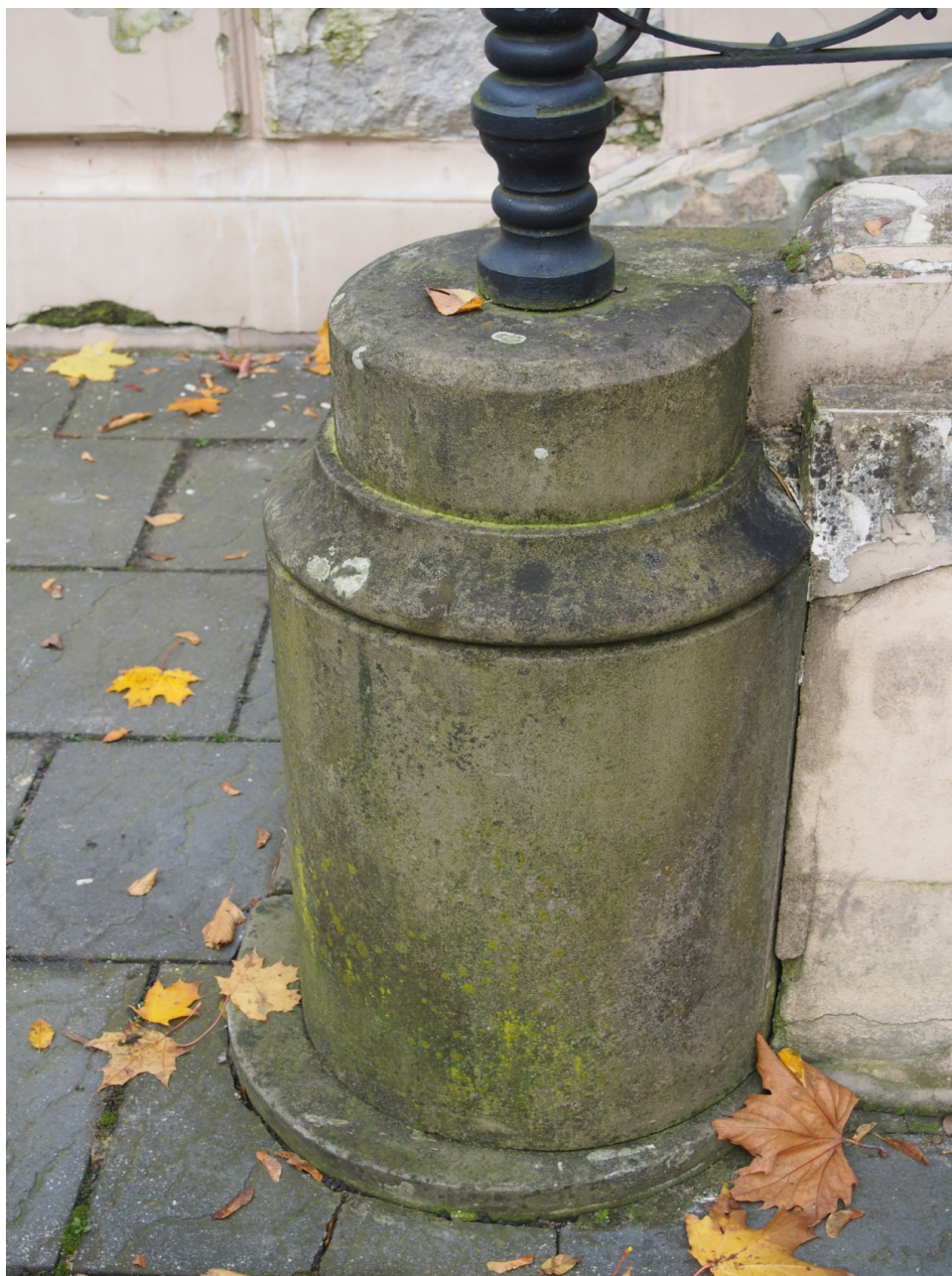
Fot. nr 4. Pałac Muzeum Mazowsza Zachodniego w Żyrardowie. Elewacja ogrodowa. Słupek prawego ciągu schodów. Słupek jest wykonany w piaskowcu i dołączony do obramienia schodów wykonanego w betonie. W górnej płaszczyźnie widoczne rozległe uzupełnienia zaprawą cementowo-piaskową.
