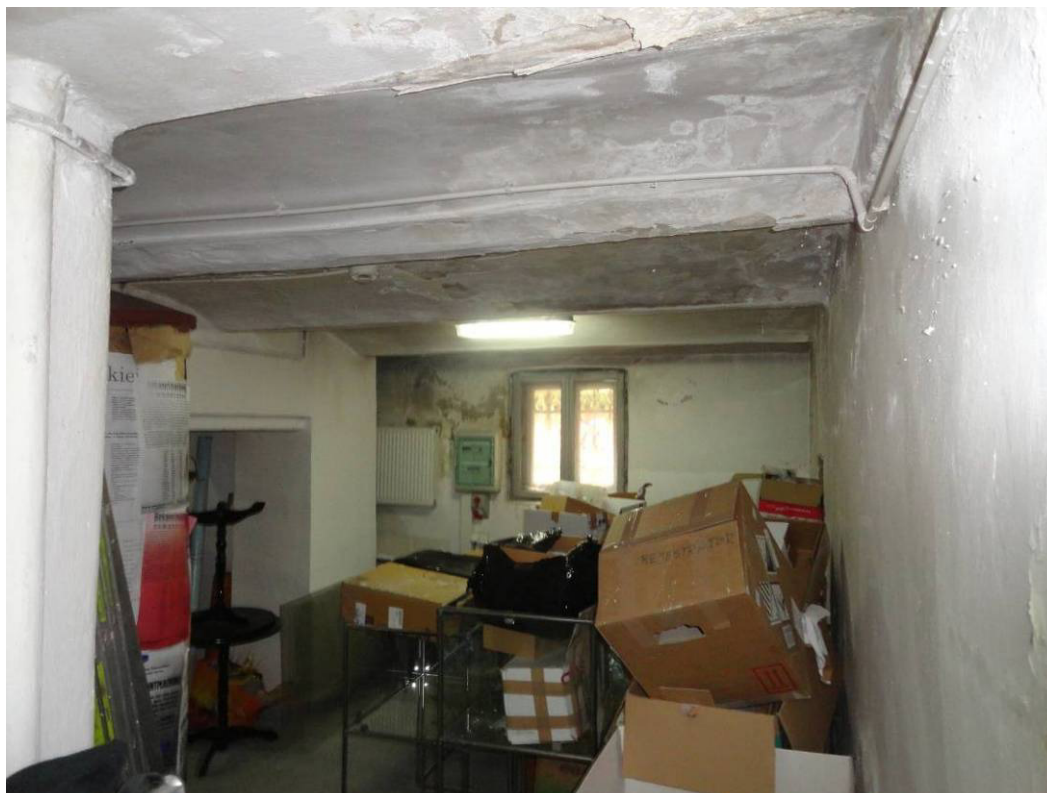
F17 Piwnice – pomieszczenie pod tarasem – widoczne silne zawilgocenia sufitów i ścian
