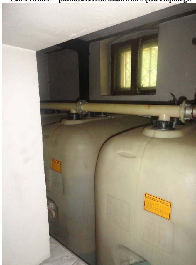
F24 Piwnice – pomieszczenie nr 19 obok kotłowni/węzła cieplnego – zbiorniki na olej
