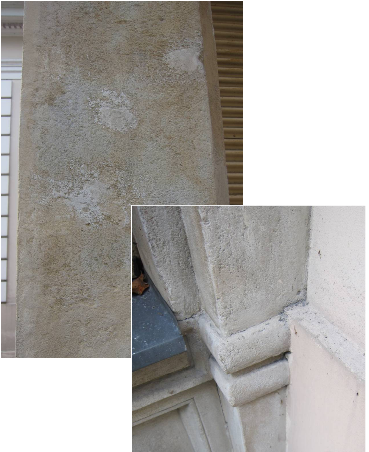
Fot. nr 3,4. Pałac Muzeum Mazowsza Zachodniego w Żyrardowie. Wykusze elewacji bocznej i ogrodowej. Fragmenty piaskowcowych słupów ścian. U góry – uzupełnienia zbyt gładkie i pokryte powłoką farby zbyt jasną i zabrudzenie powierzchni wokół. Dolne - pokazuje jak malując ścianę można zamalowano również całą płaszczyznę przylegającego doń kamienia piaskowcowego.
