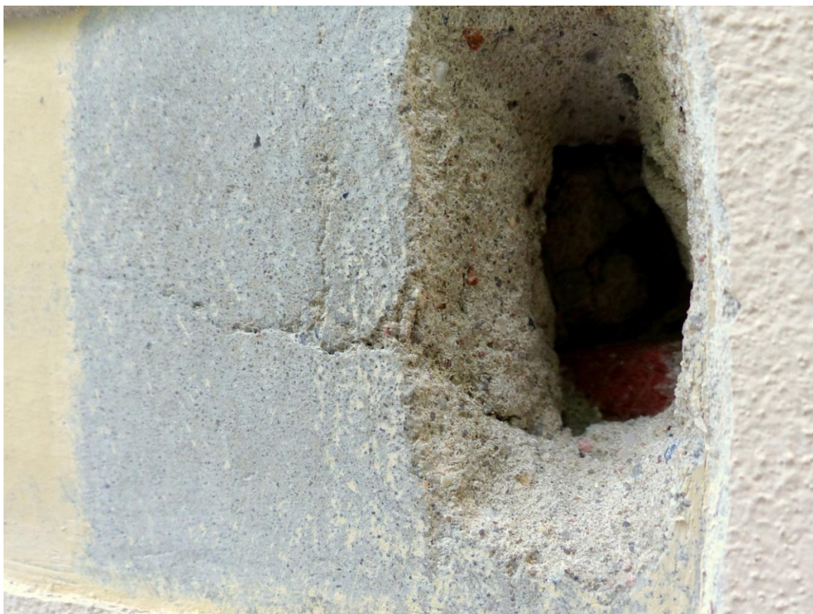
38. Sonda do muru ceglanego w odkrywce nr 1.
