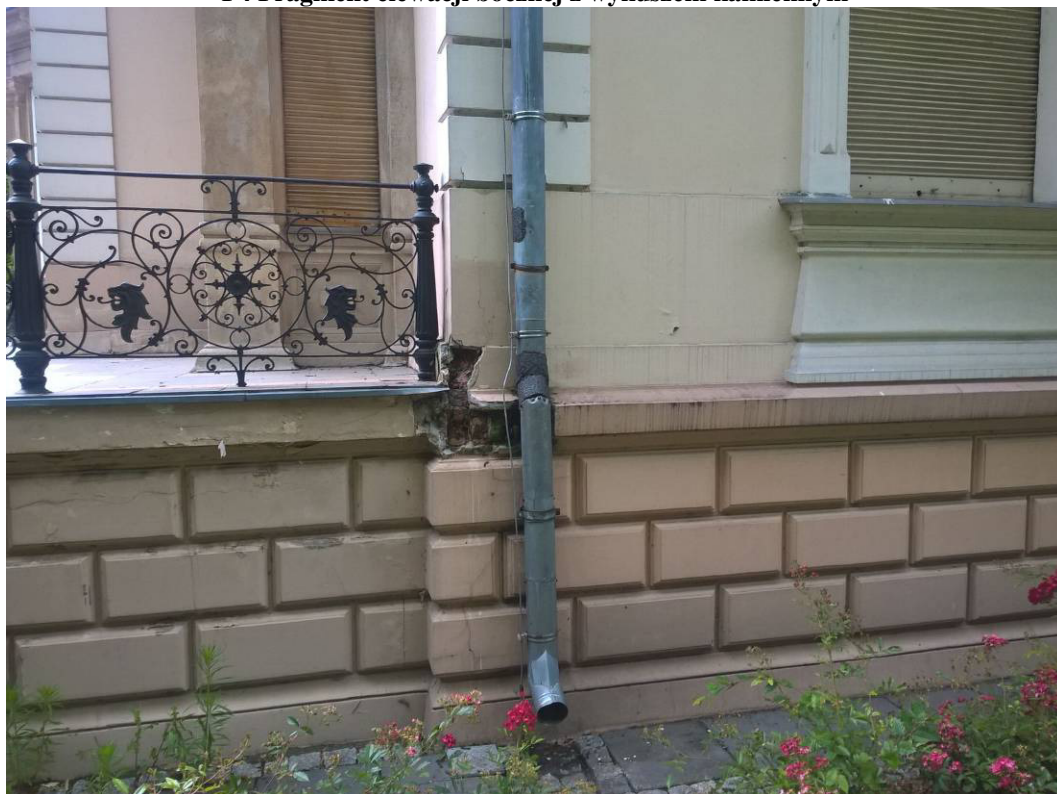
F5 Fragment elewacji bocznej – uszkodzenia przy rurze spustowej
