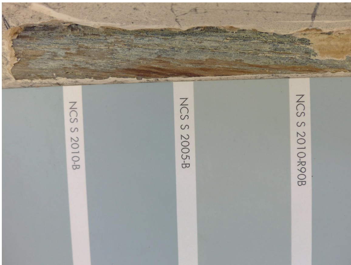
50. Fragment odkrywki nr 2 na półwałku. Przyrównanie barwy warstwy nr 8 do wzornika NCS.
