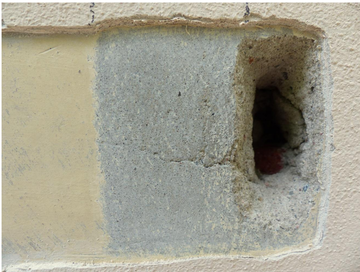
37. Fragment odkrywki nr 1 z sonda do cegły.
