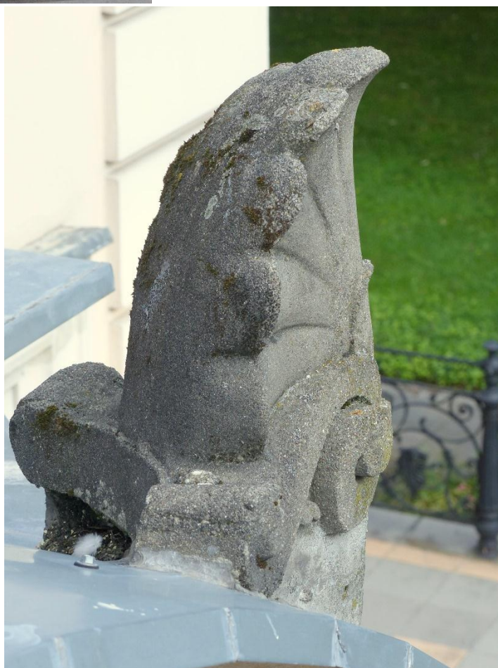
18. Prawy akroterion przy balustradzie tarasiku środkowego ryzalitu elewacji południowo- zachodniej. Odlew cementowy.
