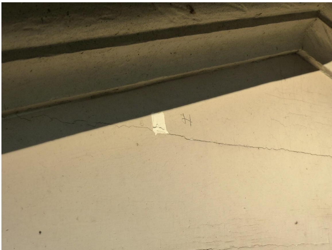
63. Odkrywka nr 3 H w pobliżu szczytu pola tympanonu.
