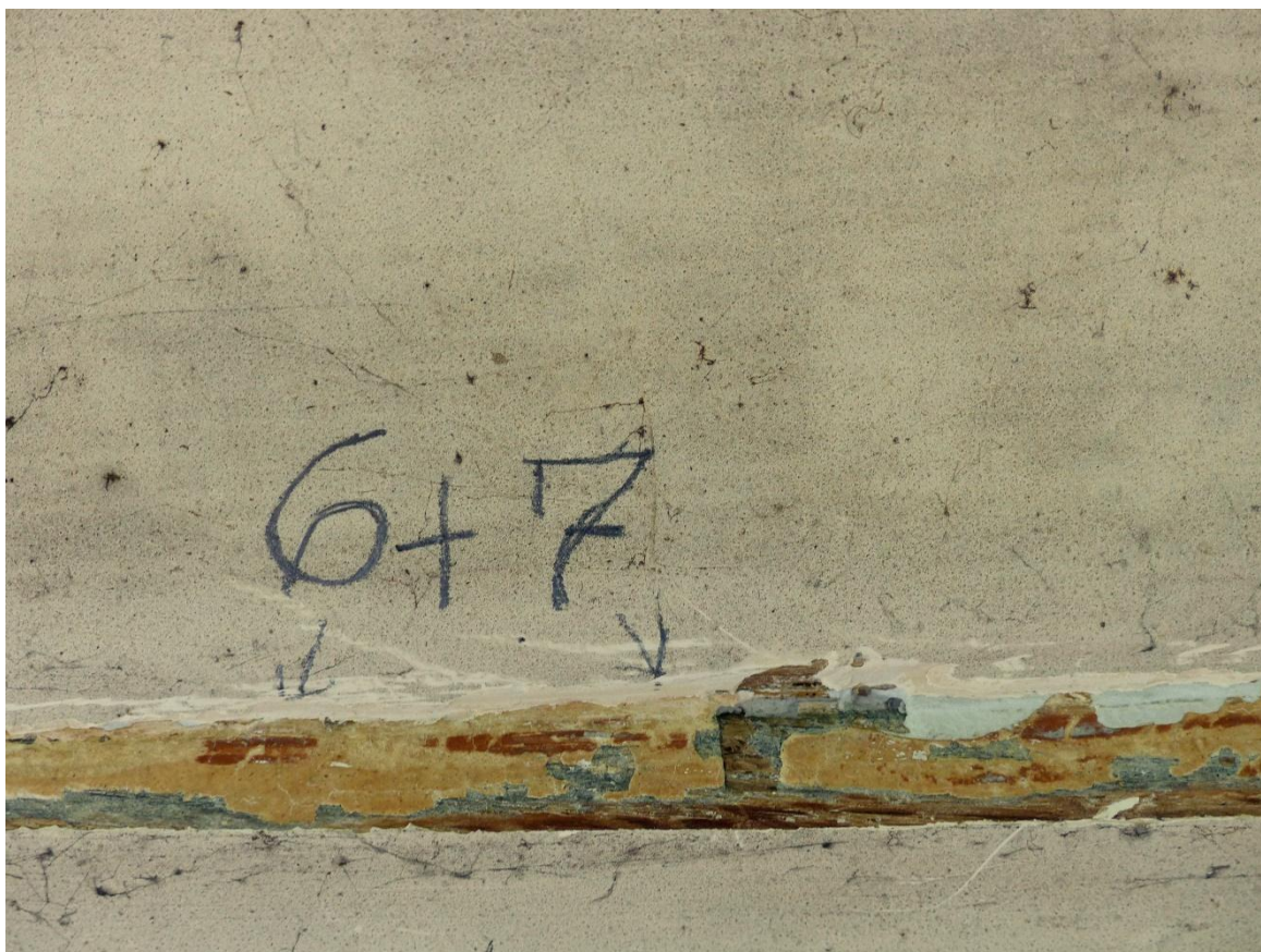
47. Fragment odkrywki nr 2 z widoczną warstwą szóstą i siódmą w partii półwałka profilu.
