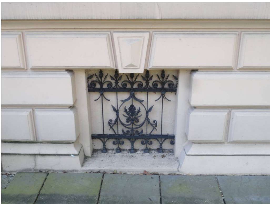
F11 fragment cokołu z zamurowanym okienkiem piwnicznym
