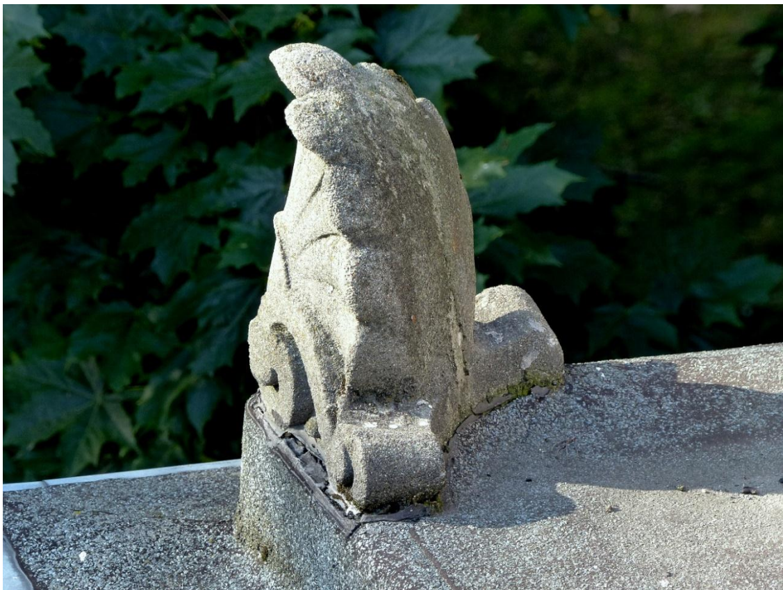
24. Akroterion z lewej strony lewej części elewacji południowo-zachodniej. Odlew cementowy.
