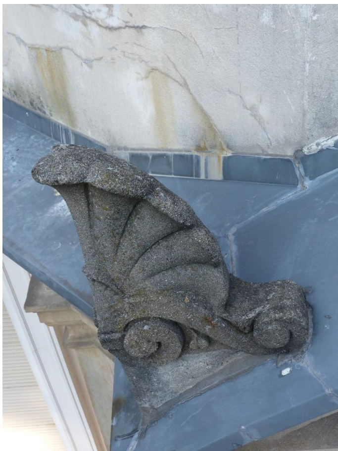
17. Lewy akroterion przed balustradą balkonu środkowego ryzalitu elewacji południowo- zachodniej. Odlew cementowy.
