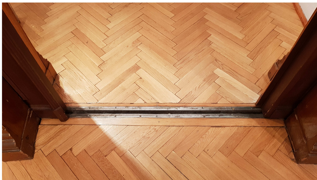
FOT. 11 – LISTWA DRZWI PRZESUWNYCH W PODŁODZE POMIĘDZY SALAMI NR 5/7 I 7/8
