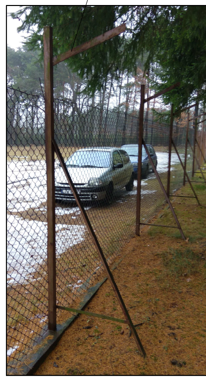
na istniejącym ogrodzeniu należy wymienić siatkę na nową ocynkowaną powleką gr. drutu 3,8mm
